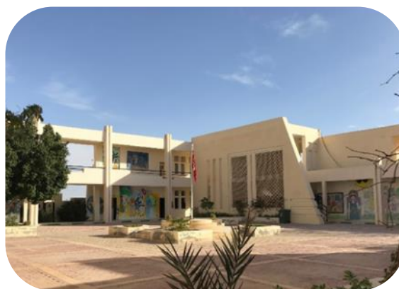
Le lycée pilote de Tozeur
