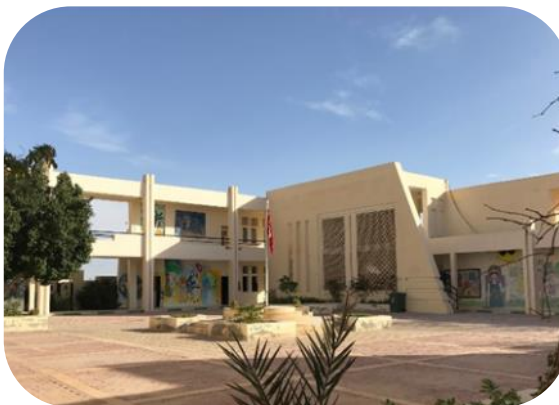
Le lycée pilote de Tozeur
